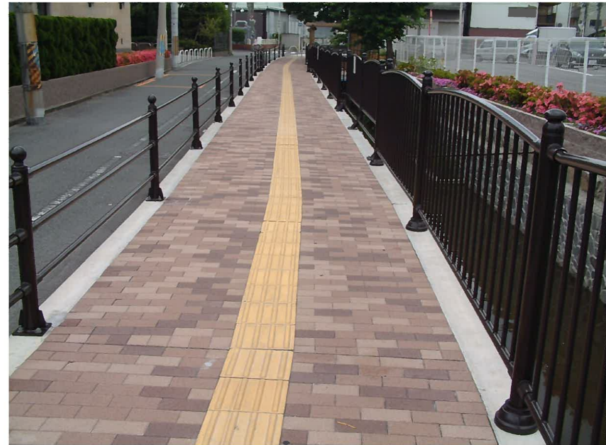
【保水性平板、保水性インターロッキングブロック】で施工した施工例
