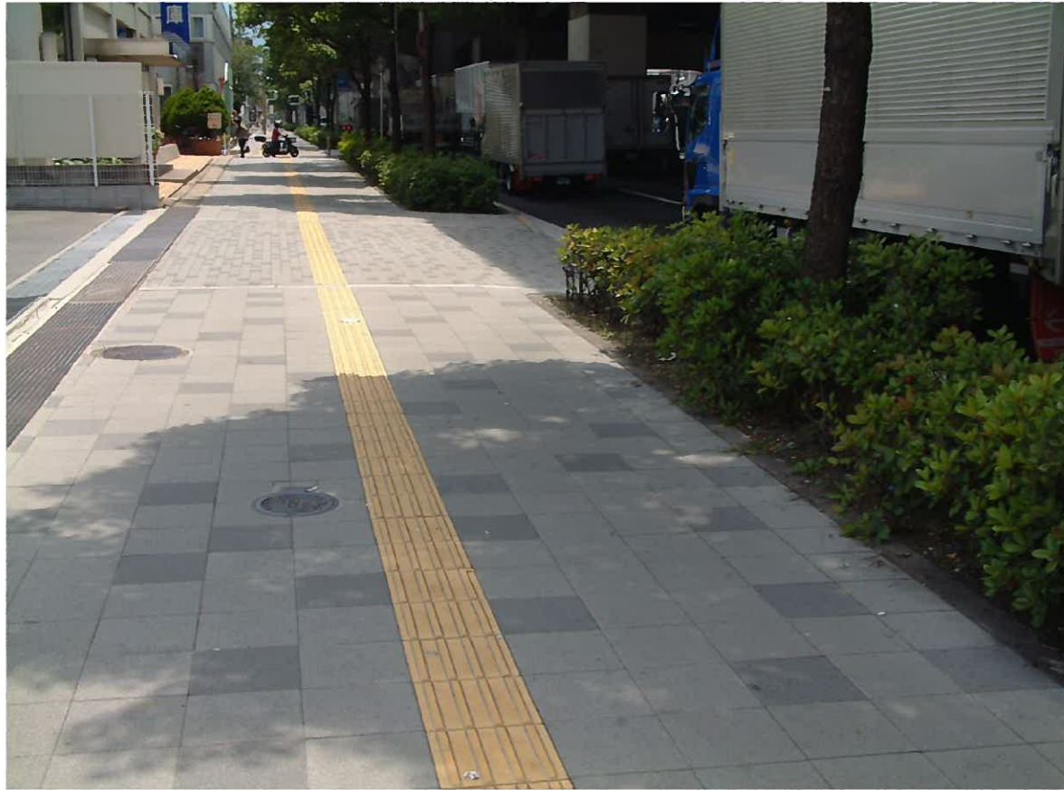
【保水性平板、保水性インターロッキングブロック】で施工した施工例
